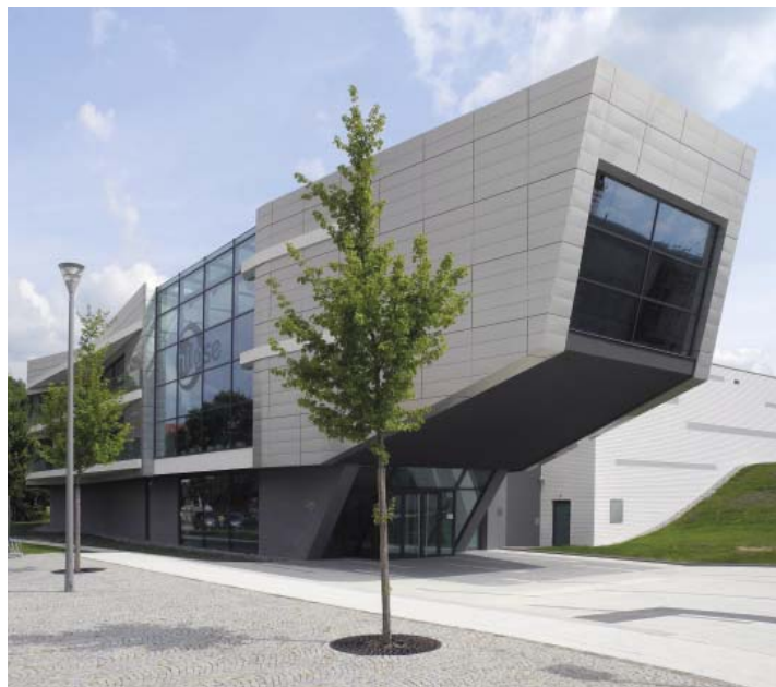
Obr. 1 Nová budova laserového centra HiLASE.
